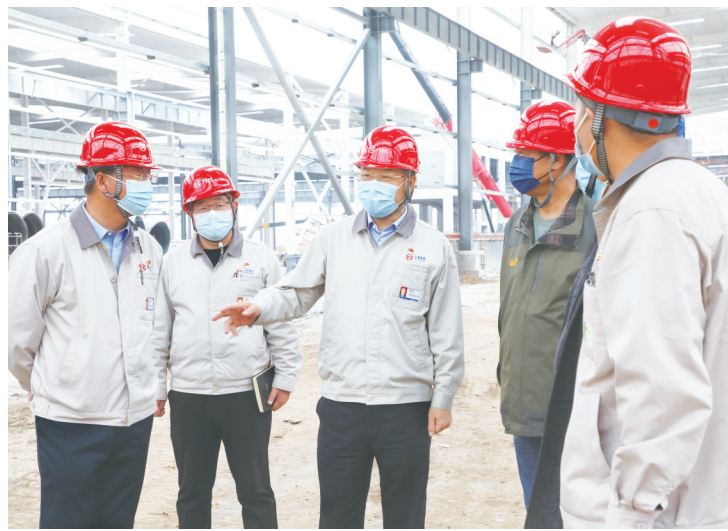
在智能高端液压挖掘机产业项目园区建设现场
